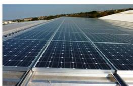
Le système d'intégration SPI 200A est un système de fixation pour modules cadrés. Il est adaptable à tous types de modules avec une hauteur de cadre maximale de 50mm. Les modules peuvent être disposés en portrait ou en paysage. Le système d'intégration a été spécialement conçu pour des toitures inclinées même à très faible pente et remplace pleinement une couverture conventionnelle.
