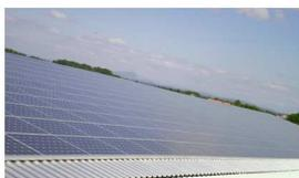
L'utilisation des matériaux résistant à la corrosion offre toutes les garanties de longévité et de robustesse. Enfin, la pose flottante des modules sur rails horizontaux évite toute tension sur les modules due à la dilatation des toitures.
