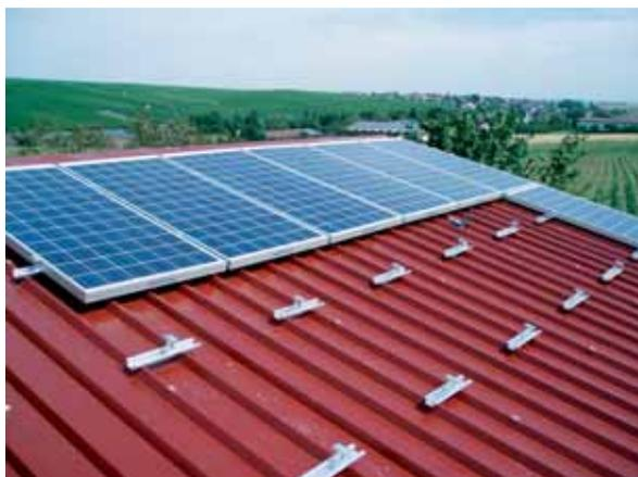
Les profilés TRI-VENT sont rivetés au toit aux endroits nécessaires à la fixation des panneaux.
