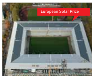
Stade de Suisse Bern Built in 2005/2007 Power 1'350 kWp
