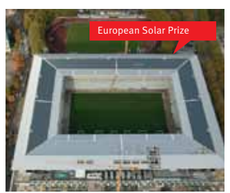
Stade de Suisse Bern Built in 2005/2007 Power 1'350 kWp
