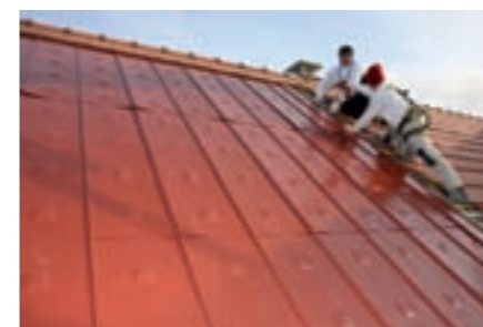
1. La pose des tôles de couverture
