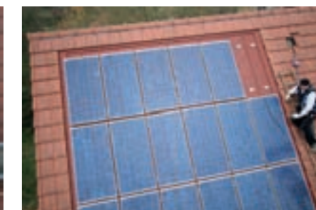
3. Le placement des modules
