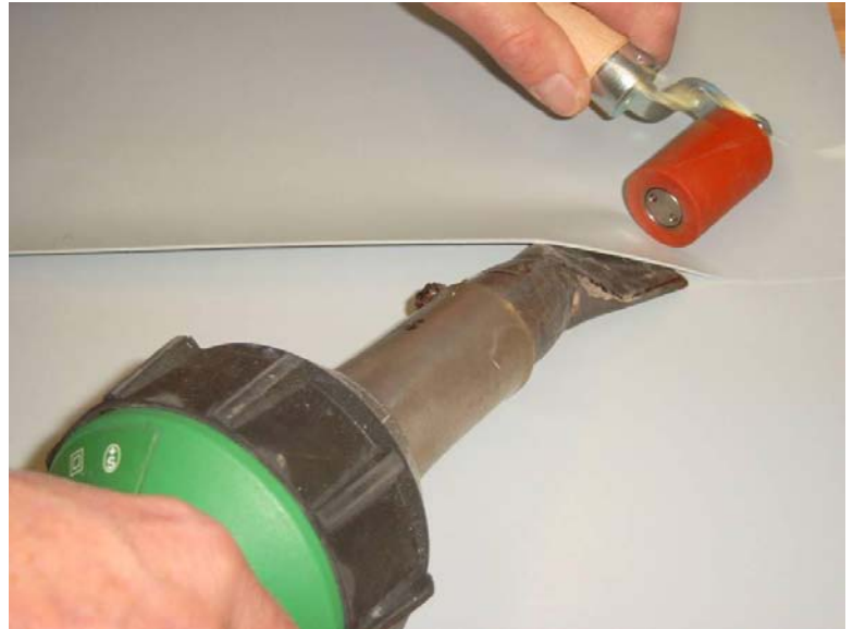
Figure 6 - Soudure à l'air chaud
